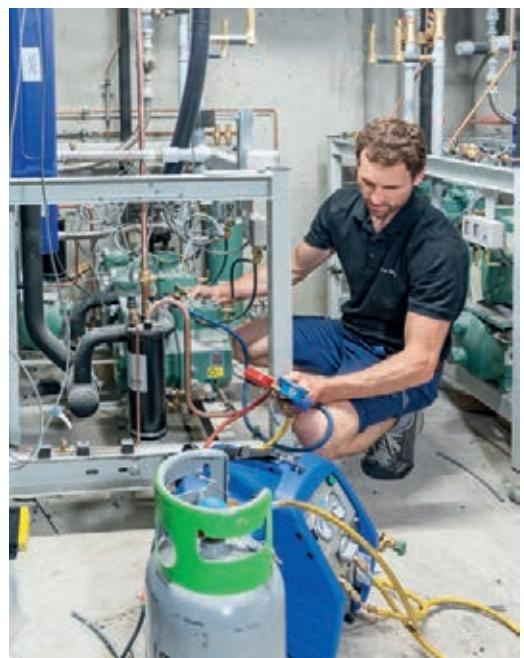
▲ Démontage Avant tout démontage, les monteurs et monteuses frigoristes doivent d'abord pomper le réfrigérant du système de refroidissement.
