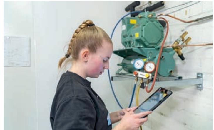
▲ Contrôle Avant la mise en service, les monteurs et monteuses frigoristes vérifient la pression et la température dans le système de réfrigération.
