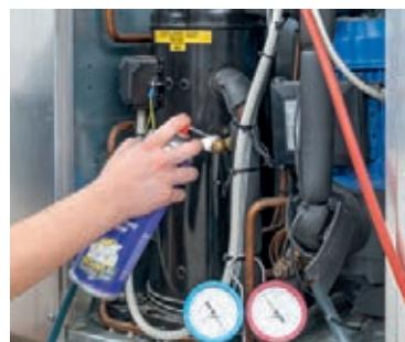
◀ Travaux de maintenance Les monteurs et monteuses frigoristes vérifient systématiquement l'étanchéité de l'installation et utilisent, pour cela, un détecteur de fuites et des sprays.
